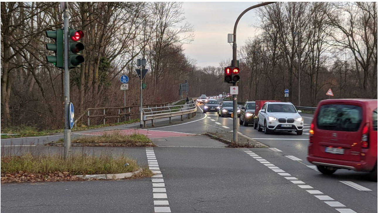
Abbildung 3: Kreuzung L269/Oberstraße in Troisdorf-Bergheim. In direkter Nachbarschaft zu der Kreuzung in Mondorf wird an diesem freien Rechtsabbieger der Gefahrensituation Rechnung getragen: Roteinfärbung der Furt mit Piktogramm, das Vz. 205 ist korrekt positioniert, auf den Zweirichtungs-Radverkehr weist das darüber befindliche Zusatzschild hin.
