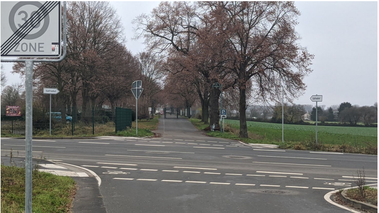
Abbildung 4: Kreuzung Südstraße/Kabelweg. Diese Kreuzung ist in kommunaler Baulast, es sind keine Roteinfärbungen vorhanden.
